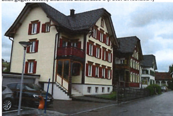
Blick gegen Nordosten, links Zielstrasse 10 (Foto: 17.05.2024)
