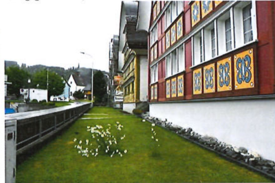
Blick gegen Südwesten (Foto: 17.05.2024)
