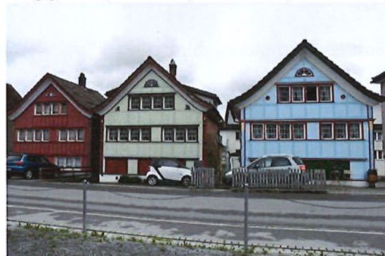
Blick gegen Nordosten, von links Nr. 35 bis 39 (Foto: 17.05.2024)
