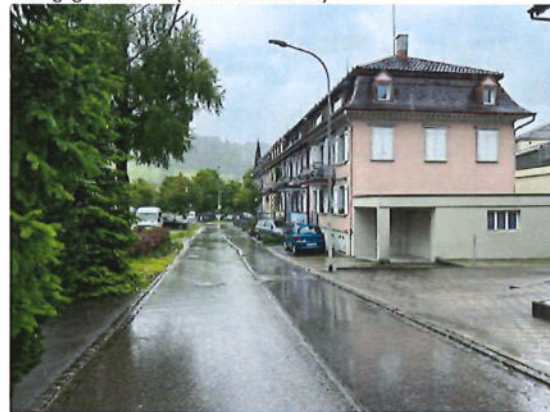
Blick gegen Südwesten (Foto: 31.05.2024)
