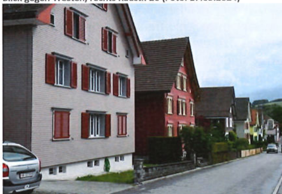
Blick gegen Nordosten, links Kastr. 16 (Foto: 17.05.2024)
